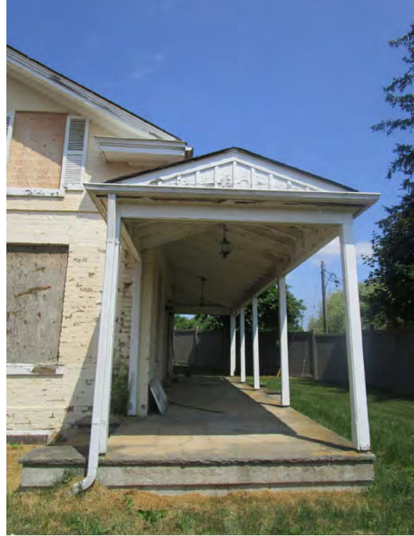
26. Main wood porch (ERA, 2019).
