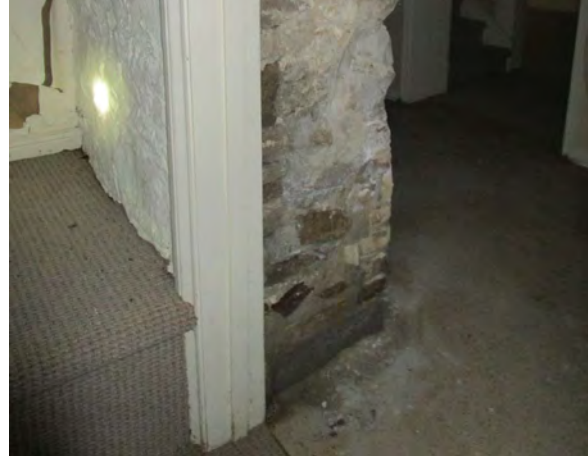
27. Stone rubble foundation (ERA, 2019).
