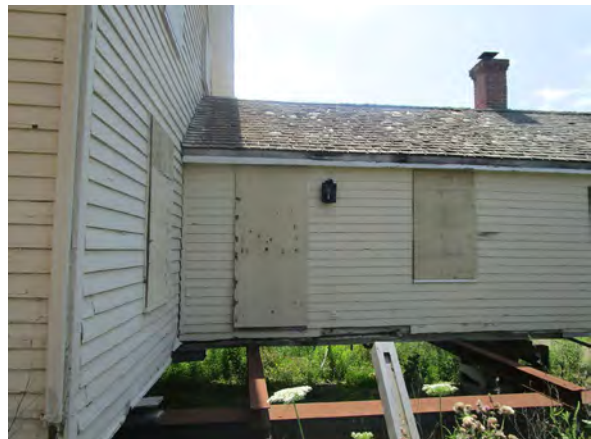
17. North elevation (ERA, 2019).
