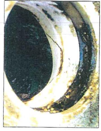
CRACK INSIDE TEE CONNECTION
